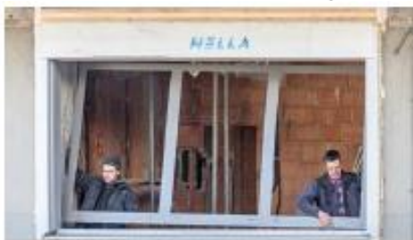
13 INSERIRE IL TELAIO FINESTRA
